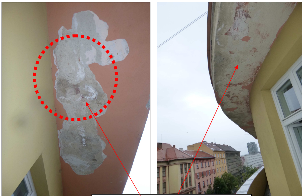
Rozsah opadávání omítek-železobetonová deska
