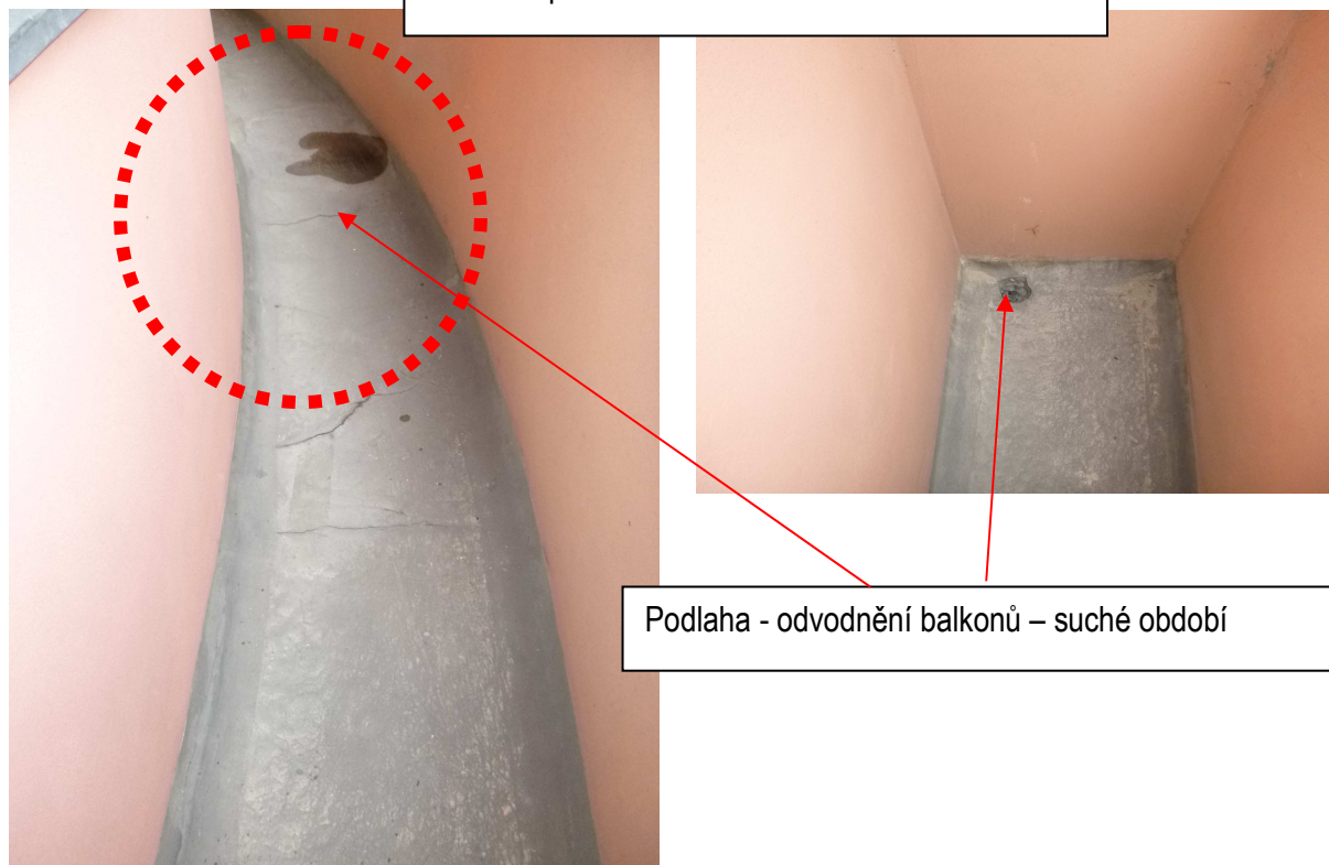
Rozsah opadávání omítek-železobetonová deska
