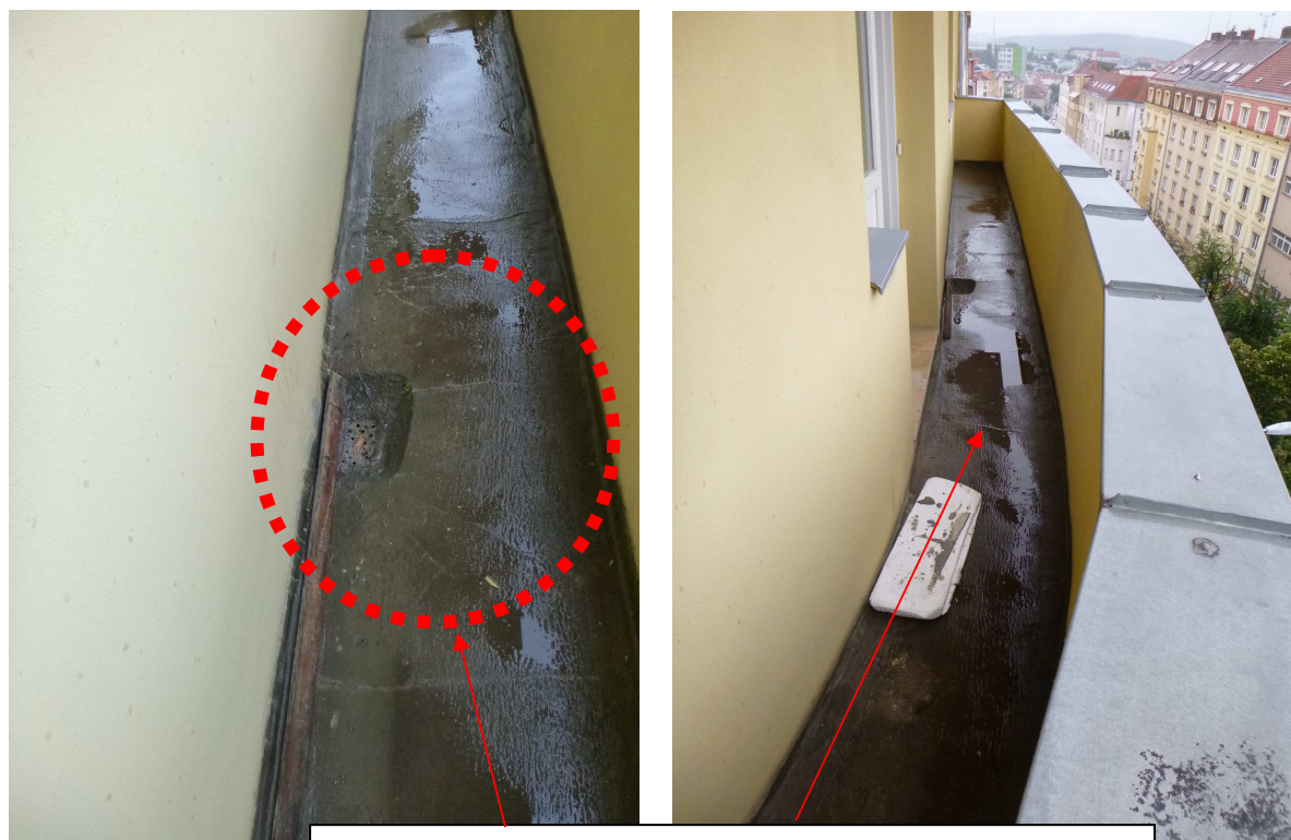
Podlaha - odvodnění balkonů – stav podlah balkonů po dešti
